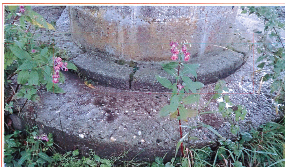
Arrière bec Pile 1 Redan large de 20cm en pied de la Pile 1 disjointoyé -Photo 10-
