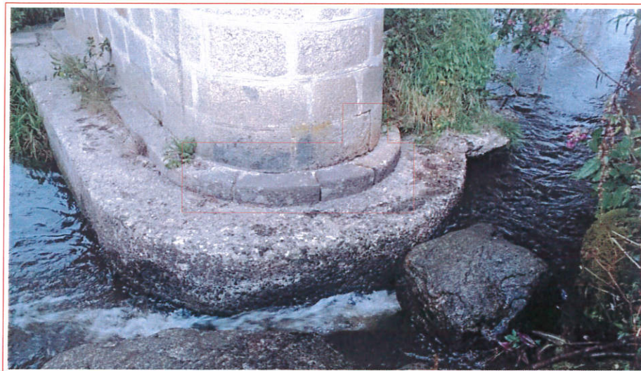
Avant bec Pile 1 Redan large de 20cm en pied de la Pile 1 disjointoyé -Photo 6-
